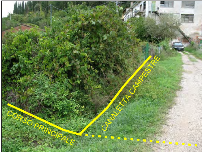
Scheda 1 foto1: inizio del tratto tombato a valle della zona in oggetto. Si noti la differenza di quota tra il fabbricato ed il fondovalle
