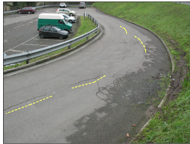
Foto 1-2 : Lesioni sul manto stradale nel tratto compreso tra la strada provinciale ed il parcheggio inferiore
