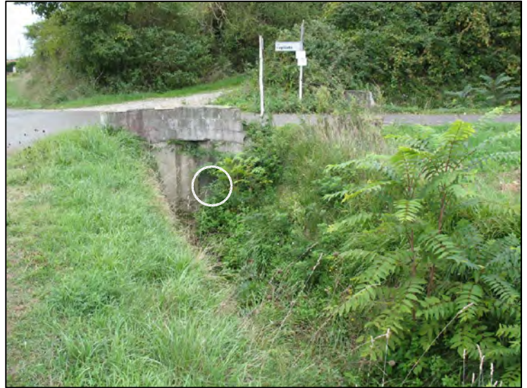
Comparto n°9 foto 2: panoramica del tombamento del corso principale al di sotto della Via Capilato
