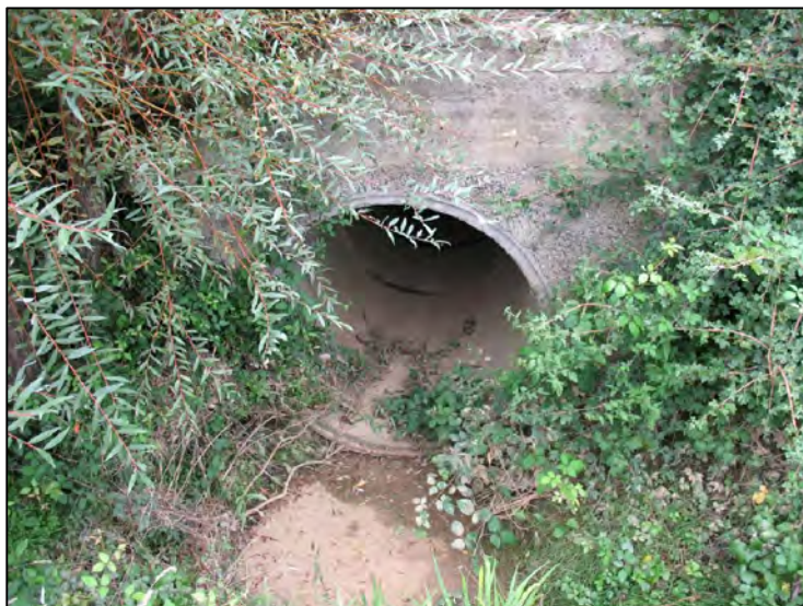
Comparto n°9 foto 3: particolare del tombamento del corso principale al di sotto della Via di Lungomonte (diametro 150 cm)
