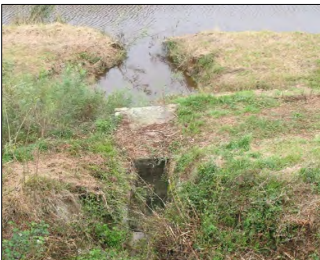
Comparto n°9 foto 3: particolare del tombamento del corso principale al di sotto della Via di Lungomonte (diametro 150 cm)
