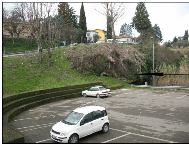
Foto 5 : Panoramica del parcheggio a valle della Strada Provinciale. In angolo affiorano i conglomerati cementati intercettati nel sondaggio ed al cui tetto si sono interrotte le prove penetrometriche
