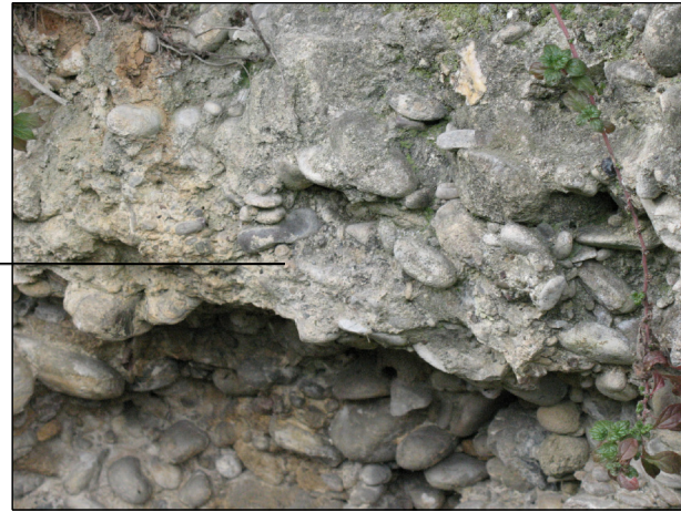
Foto 6 : Particolare del conglomerato cementato che si estende anche al di sotto dell'area dei macelli per uno spessore di circa 8 metri
