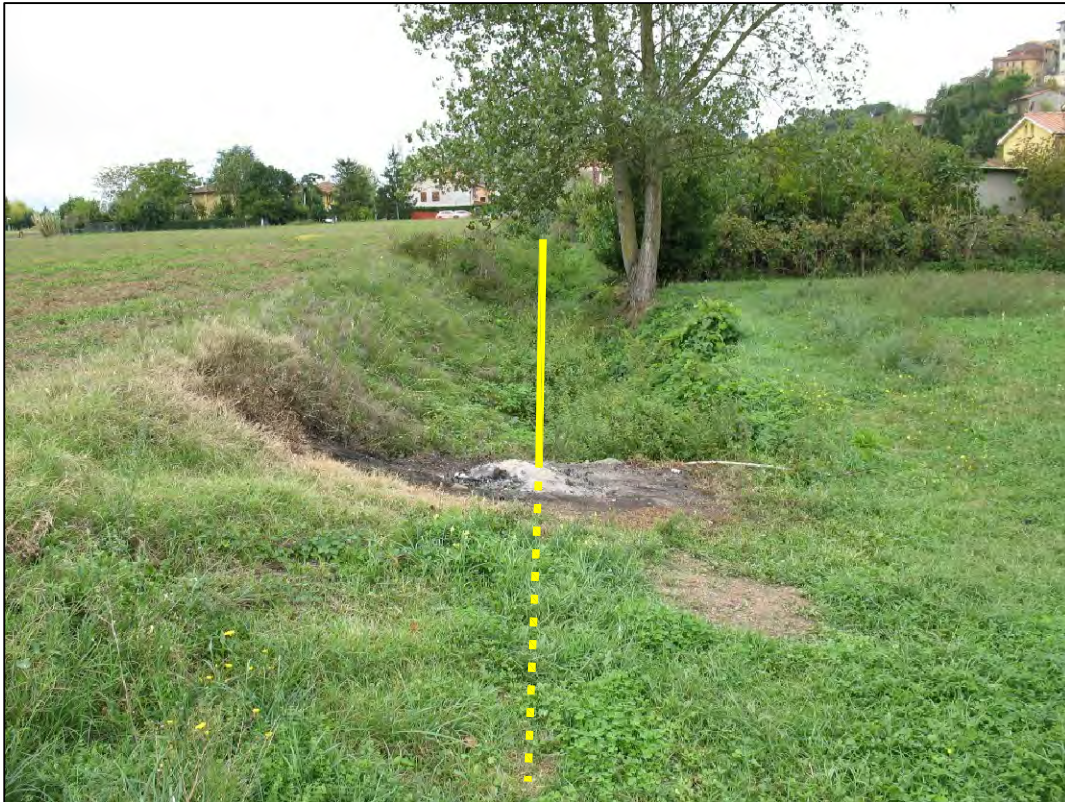
Comparto n°10 foto 1: particolare del fosso che scorre a valle del comparto n°10, con in primo piano il tratto tombato.
