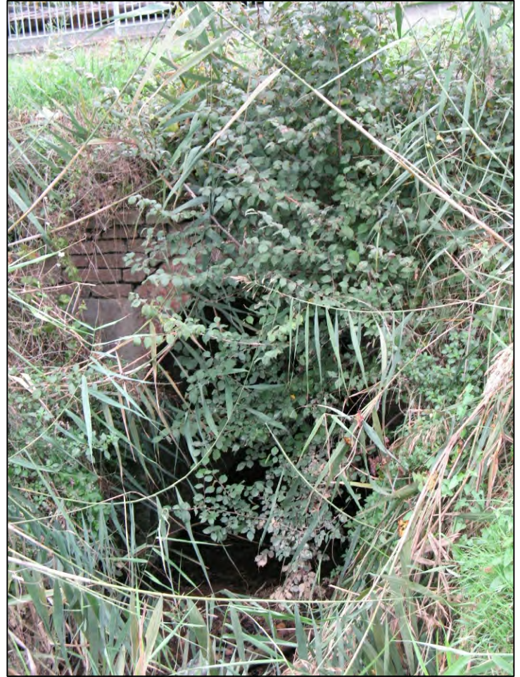
Scheda 1 foto 2: uscita del tombamento a valle della Via di Lungomonte
